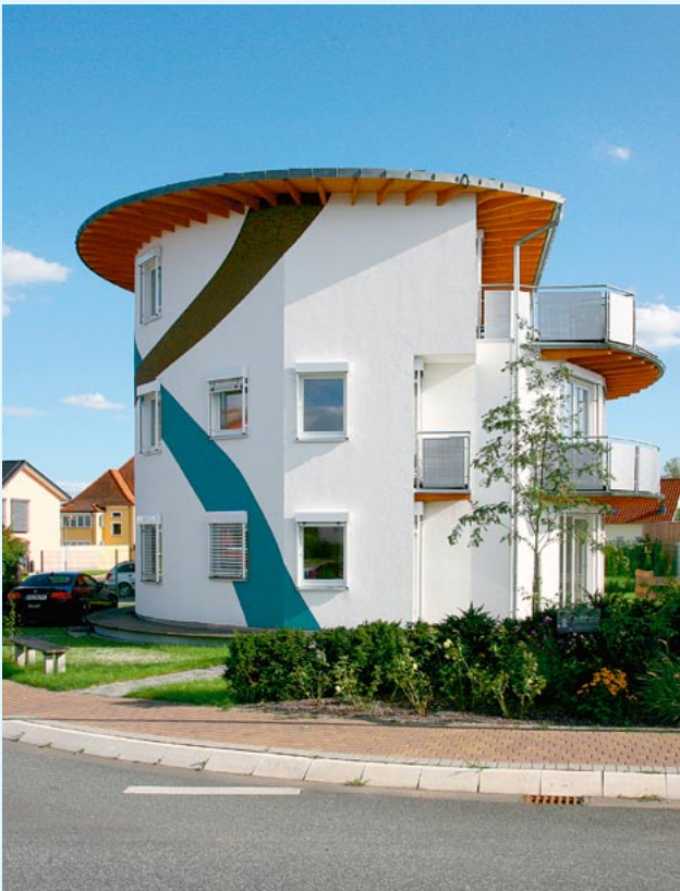
↑ Obracający się dom pasywny braci Rinn. Powierzchnia użytkowa: 241 m 2 . Konstrukcja: prefabrykowany szkielet drewniany. Zapotrzebowanie na ciepło: 13 kW/m 2 /rok
