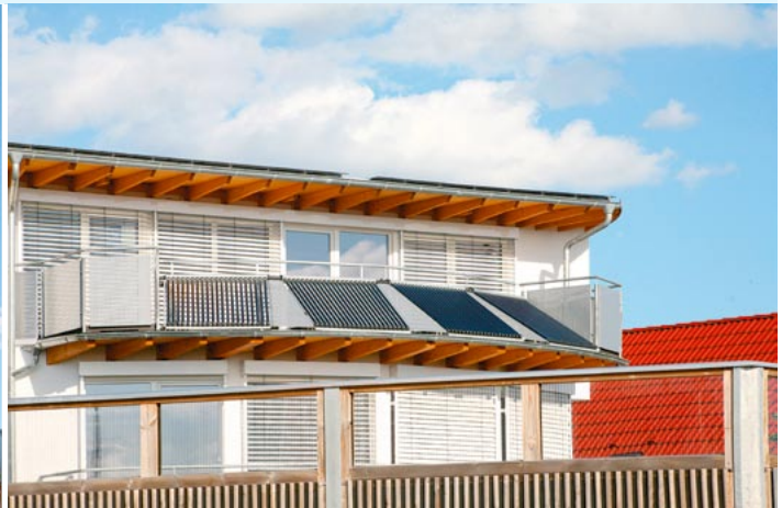
↑ Instalacja do pozyskiwania energii odnawialnej: kolektory próżniowe oraz ogniwa fotowoltaiczne o mocy 8,3 kW. Ten dom zarabia na sobie – produkuje zdecydowanie więcej prądu, niż zużywa
